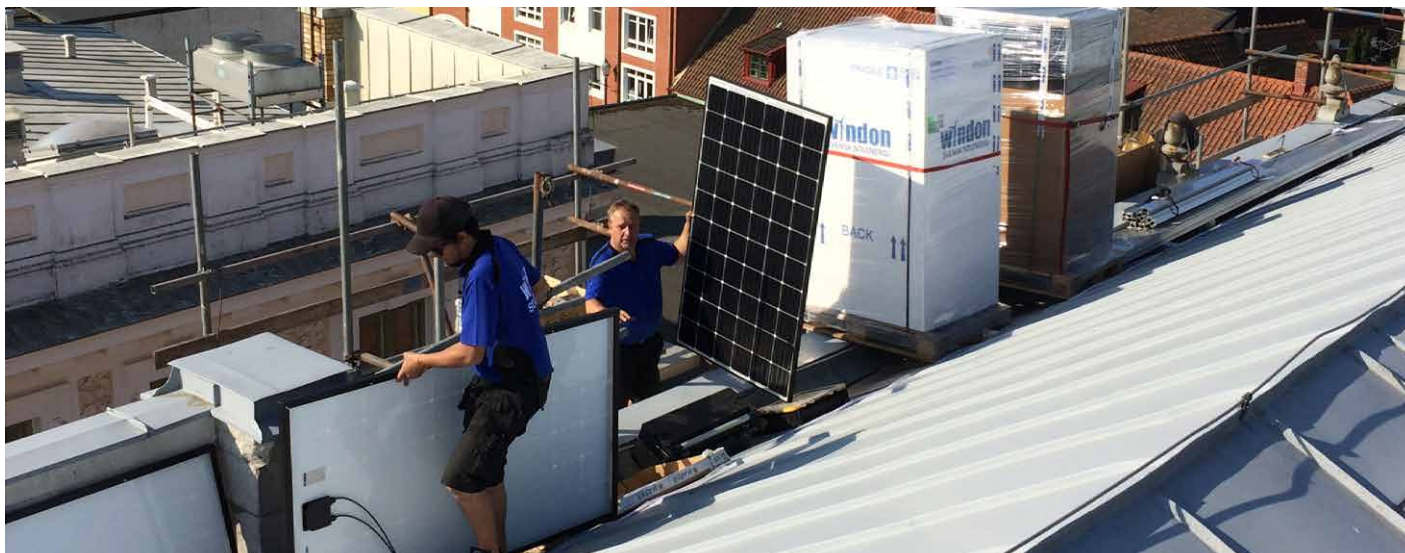
2018 installerade vi solceller på taket till vårt huvudkontor i Ystad.
